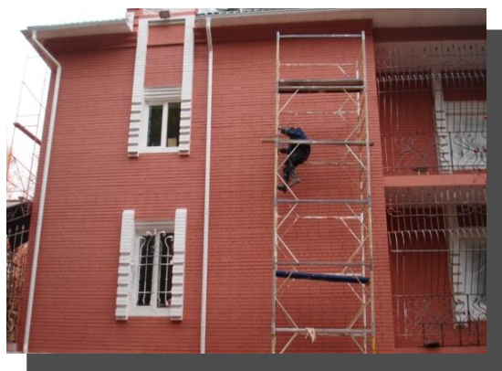
г. Ставрополь - Утепление фасада коттеджа
