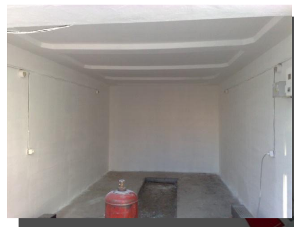
г. Ставрополь- утепление гаража
